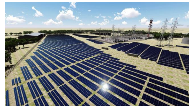
Proyecto: planta Solar Yumbo
