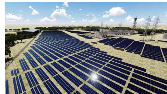
Proyecto: planta Solar Yumbo
