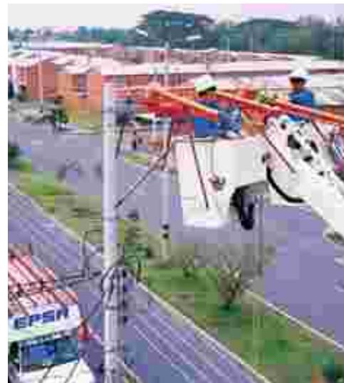
El equipo de trabajo de Línea Viva realiza mantenimientos en las redes sin interrumpir el servicio.
