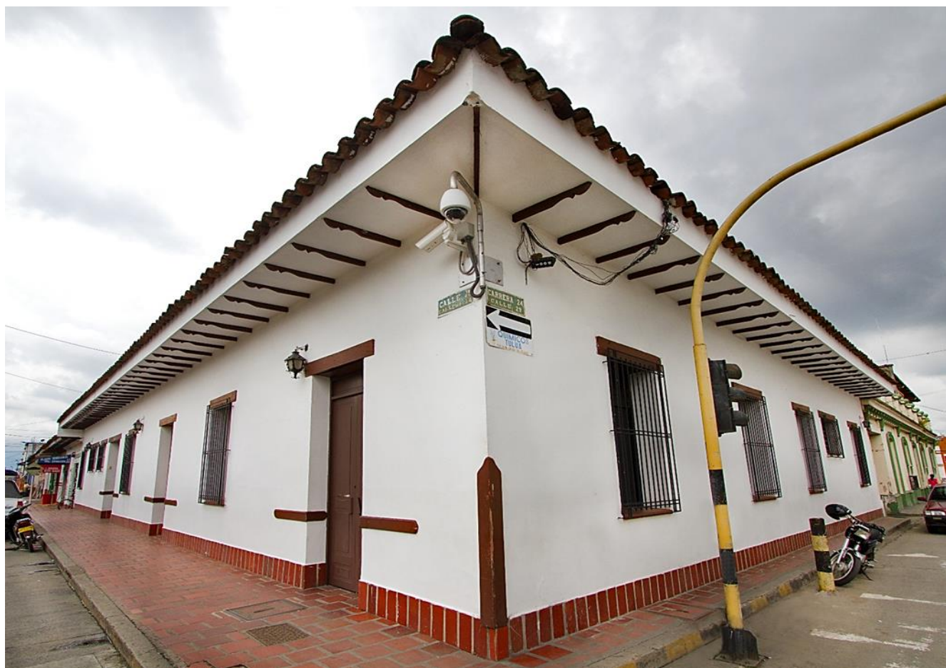
Sede CETSA – Tuluá
