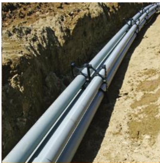
Figura No. 9.4 Banco de ductos con separadores
