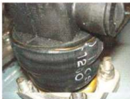
Figura No. 3.4 Sellamiento de la unión de conector tipo muelle a la boquilla del transformador, con manga termocontráctil
