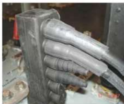
Figura No. 3.5 Sellamiento de la unión entre el cable de baja tensión y el conector tipo muelle con manga termocontráctil
