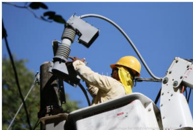
Figura 1. Instalación de cubierta aislante para cortacircuitos
