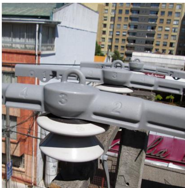
Figura 3. Dispositivo de protección de fauna para bujes primarios y DPS.
