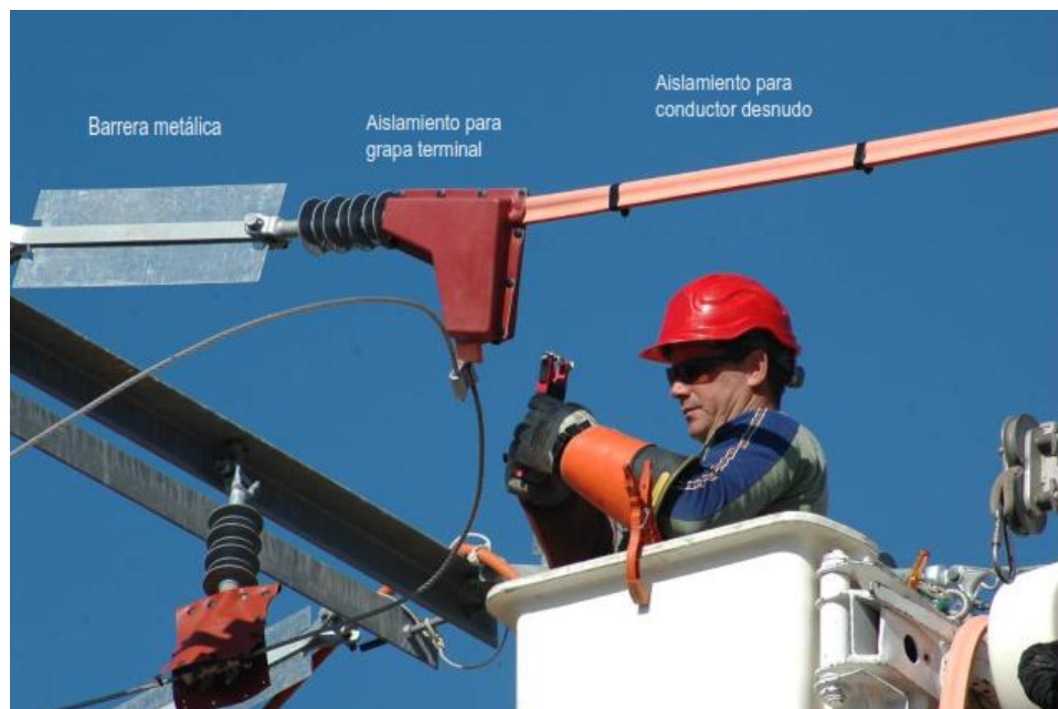
Figura 6. Vista panorámica de conjunto doble terminal con protección de avifauna
