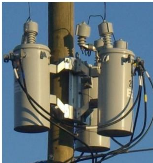
Figura 4. Guarda aislante para restringir el acceso de animales trepadores a puntos energizados
