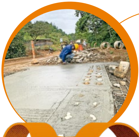
Construcción de placa huella en el municipio de Suárez, Cauca.
